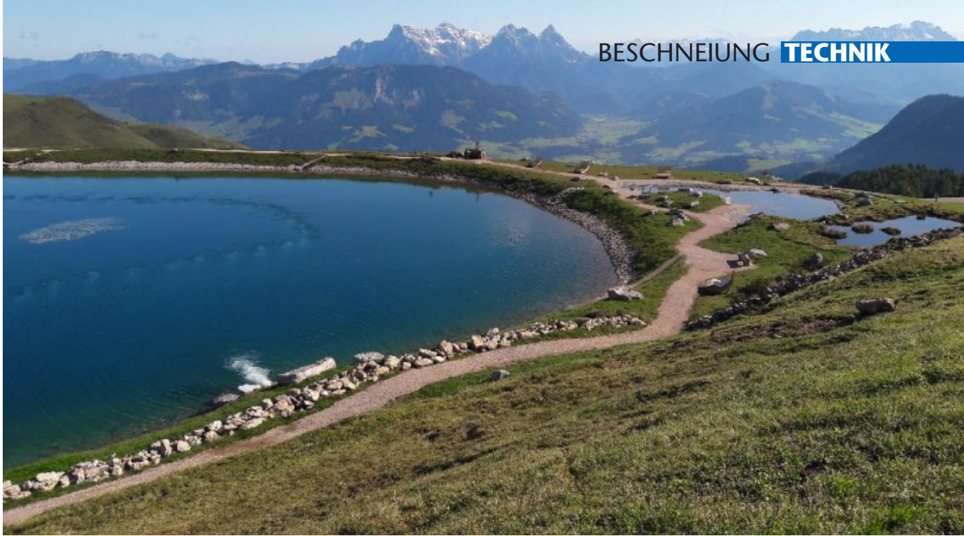
Speicherteich Hornköpfl, Schneeanlage Kitzbüheler Horn (A).
