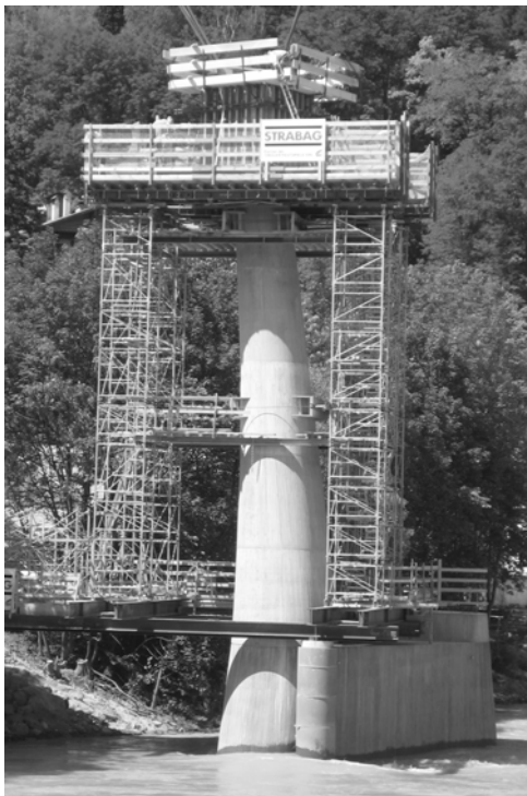
Bild 8. Pylonschalung
