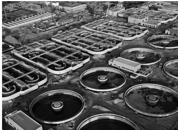
Abb. 4 Belebungs- und Nachklärbecken nach dem Wassertest
