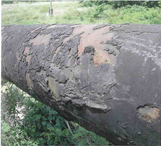
BILD 2: Defekte Bitumenumhüllung
