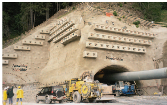
Bild 2 Ankerbalken für die Sicherung der Einschnitte der Ostportale.
