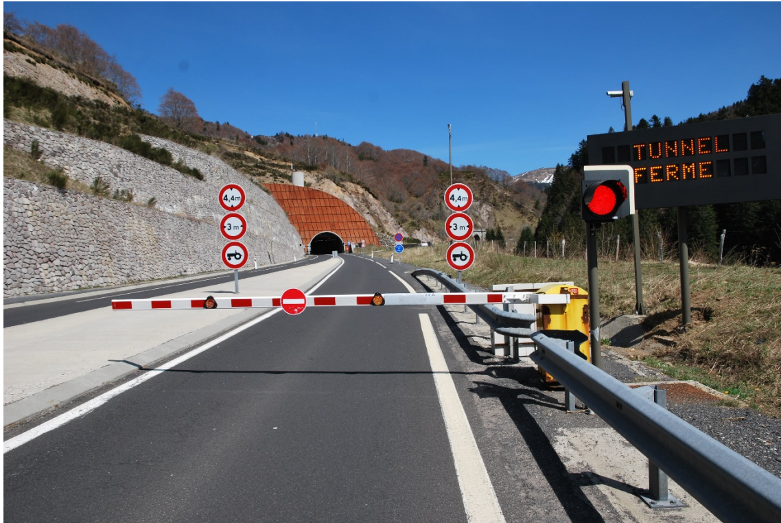
Fig. 2: Cierre efectivo del túnel impuesto por las barreras, Túnel de Lioran (Francia) © CETU
