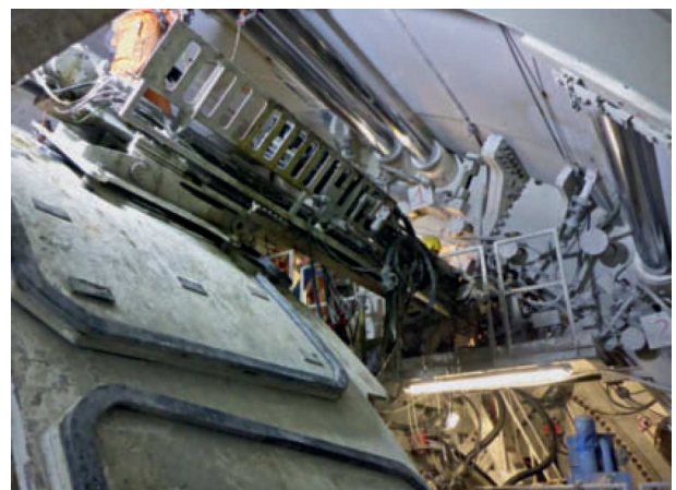
6 Bohrarbeiten Bauhilfsmassnahme GFK-Anker vom 8. Juli 2016 ab Erektor
