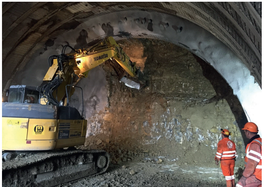
Abb. 8: Konventioneller Vortrieb im Schutze eines Rohrschirms
