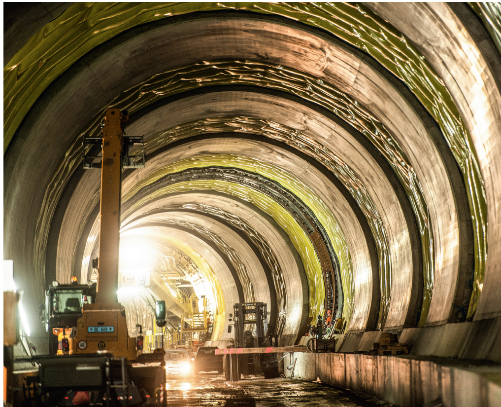
Abb. 6: Betonarbeiten Innengewölbe
