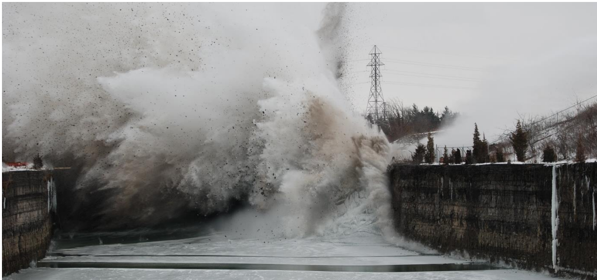
Abbildung 7-3: Sprengung der Felsbarriere am 12-02-2013
