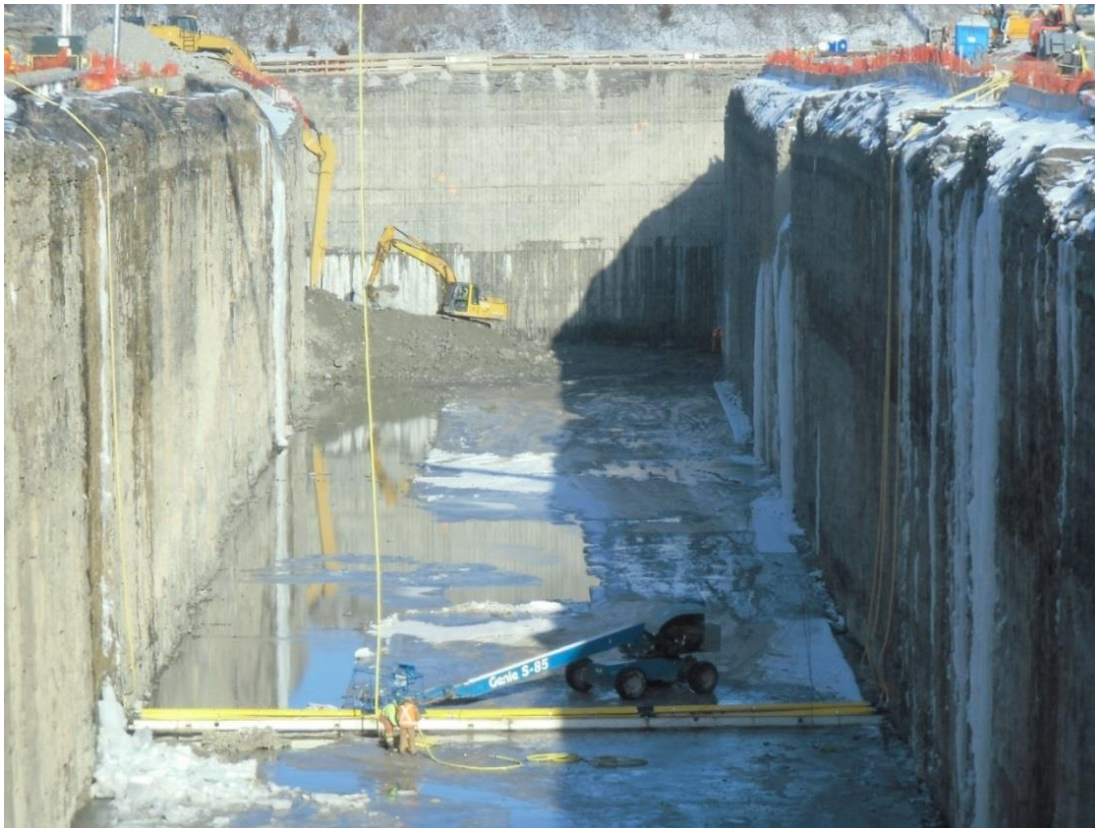
Abbildung 7-2: Montage des Luftblasenvorhanges mit der Felsbarriere im Hintergrund
