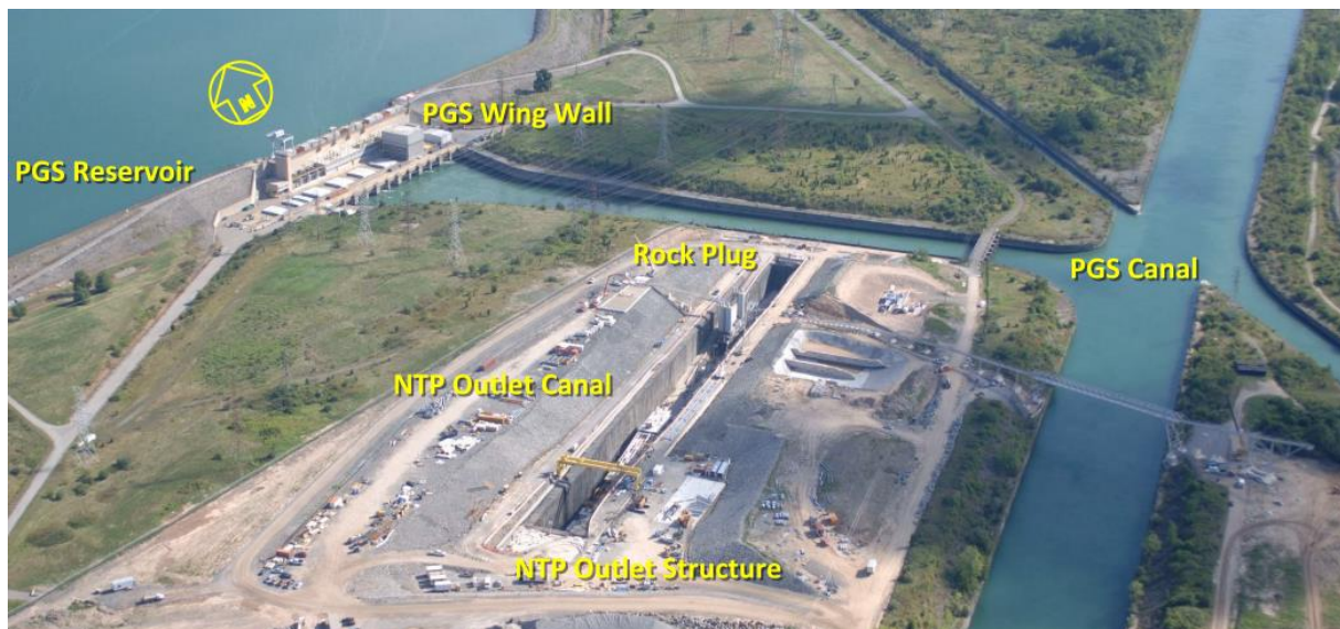
Abbildung 3-1: Auslaufkanal (vorne) mit Felsbarriere zum PGS Kanal (Mitte) und PGS Pumpspeicherwerk (links)
