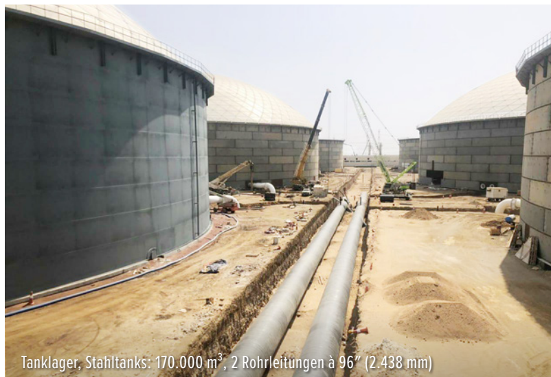
Rohrverlegung, 2 Pipelines à 72" (1.829 mm)
