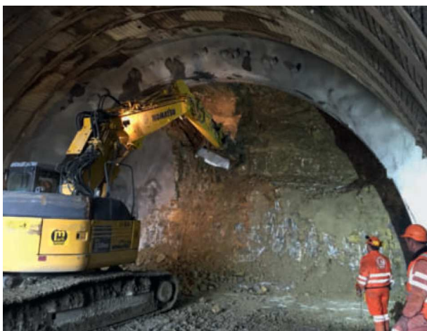
9 Konventioneller Vortrieb im Schutz eines Rohrschirms Conventional drive protected by pipe roofing umbrella
