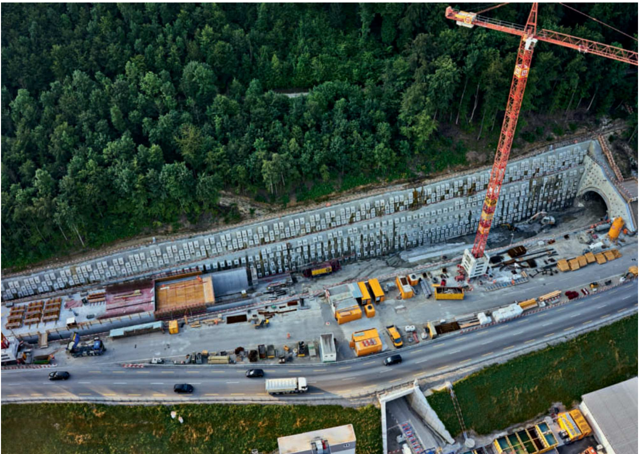
8 Blick auf den Voreinschnitt des Tagbautunnels Ost (Wöschnau) View of the open portal cut of the cut-and-cover east tunnel (Wöschnau)
