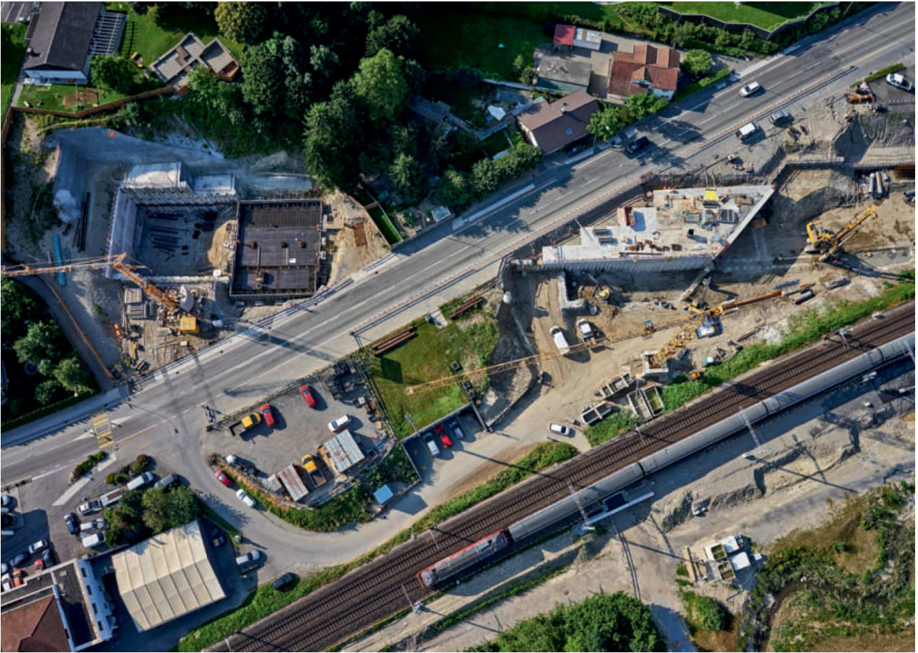
10 Blick auf die Zielbaugrube am Westportal (Gretzenbach) View of the target excavation wall at the west portal (Gretzenbach)
