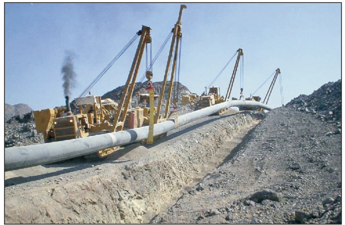
Abb. 8 Pipeline-Verlegung
