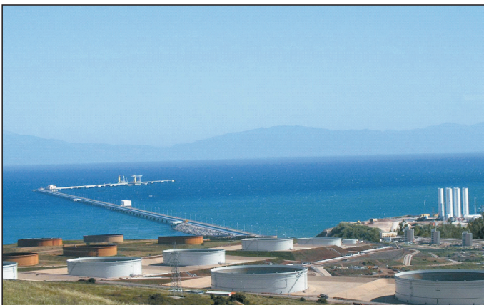
Abb. 7 Tanklager und Tankerbeladeanlage Ceyhan
