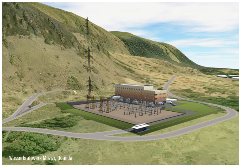
Pumpspeicherwerk Atdorf, Deutschland
